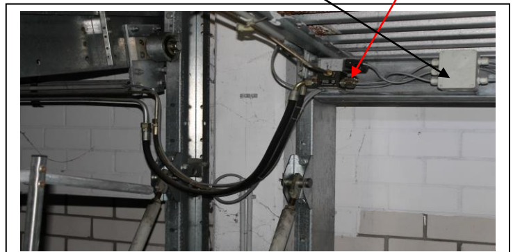
Bild 4: Hydraulikarm mit Ventil
