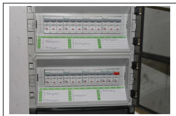
Bild 12: Sicherungskasten mit Schutzschaltern für die elektrische Zuleitung zu den Hydraulikpumpen und Stelleinheiten mit Notausschalter
